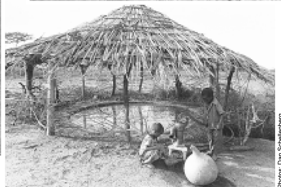
Enfants utilisant une petite pompe manuelle en face d'un petit réservoir couvert pour éviter l'évaporation et protéger enfants et animaux d'une chute possible.
