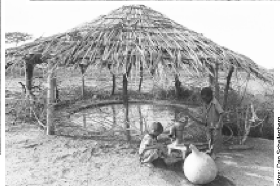
Niños usando una pequeña bomba de mano frente a un pequeño tanque de agua cubierto para evitar la evaporación y protegerlo del ganado y de los niños
