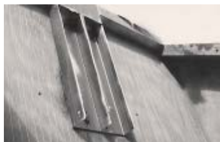
La bouche d'air métallique à l'arrière du séchoir permet à l'air chaud de s'échapper par le haut du séchoir.
