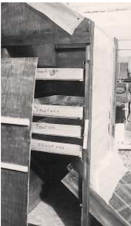
Vista do secador com a lateral removida, mostrando a entrada e as bandejas.
