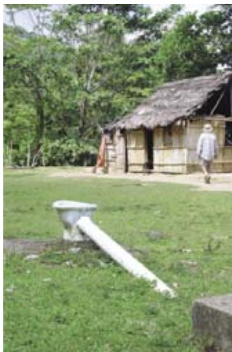
Uma latrina inacabada e abandonada em Honduras: resultado do planejamento e do design inadequados.
