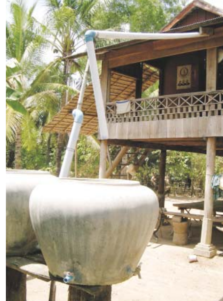
Maison au Cambodge : collecte très économique des eaux de pluie de toiture à partir d'un toit en tôle ondulée, de tuyaux en plastique dur et de jarres en ferrociment pour le stockage.
