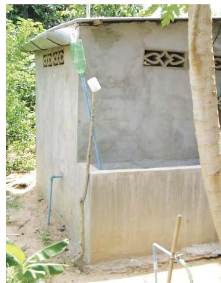
Récupération des eaux de pluie de la toiture d'une latrine au Cambodge, à l'aide d'une bouteille usagée de boisson gazeuse, un tuyau en plastique dur, une tôle ondulée et une citerne de stockage en brique. Ce concept est particulièrement utile car il fournit de l'eau pour se laver les mains directement à la porte de la latrine.
