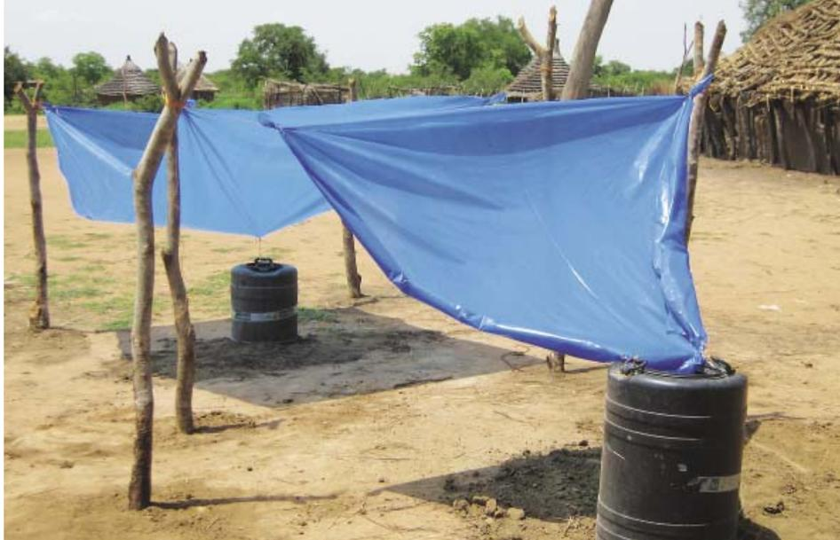
Sistema de captação de água da chuva de custo ultra baixo no Sudão do Sul, usando uma lona plástica, estacas de madeira e um tambor de combustível de plástico.
