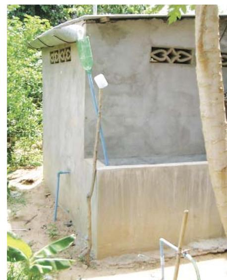
Captación del agua de lluvia desde la azotea de una letrina en Camboya, usando una botella vieja de refresco, tubo plástico duro, hojas acanaladas de hierro y un tanque de ladrillos para almacenamiento. Este concepto es especialmente útil pues proporciona agua para lavarse las manos en la misma puerta de la letrina.
