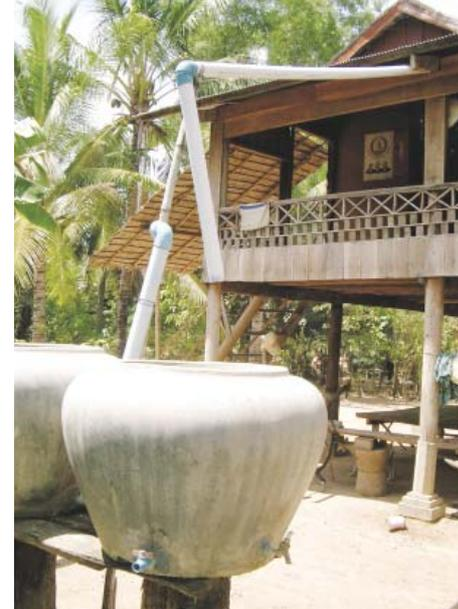
Captación del agua de lluvia desde una azotea, a muy bajo costo, usando un techo de hojas acanaladas de hierro y tarros de ferrocemento como almacenamiento en una vivienda en Camboya.
