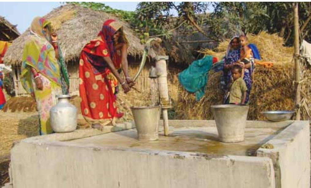
Un puits tubé surélevé sur une plateforme permet aux communautés d'avoir de l'eau de consommation propre lors des inondations.
