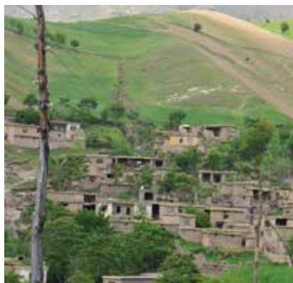
La organización asociada de Tearfund ha instalado 325 microcentrales hidroeléctricas en las zonas rurales de Afganistán.
