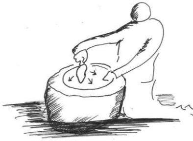
Retire la cacerola y pule la superficie de la hornilla con un raspador.
