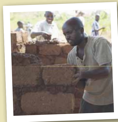
Les savoir-faire en matière de construction sont toujours utiles. (Photo : Debora Randall / Samaritan's Purse)
