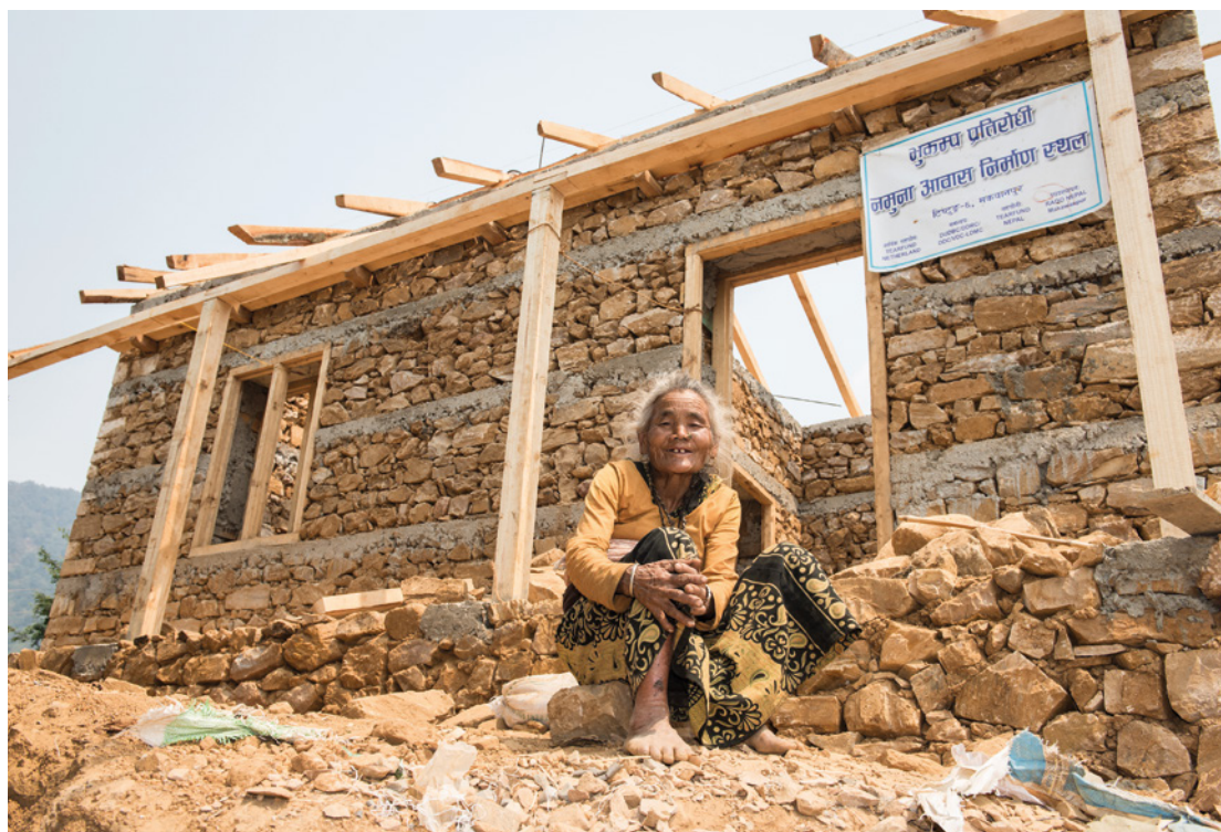
Une femme se tient devant sa nouvelle maison résistante aux tremblements de terre, toujours en construction. Photo : Eleanor Bental/Tearfund
