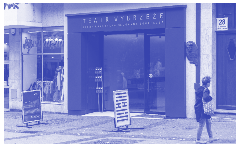
Wejście do budynku Sceny Kameralnej w Sopocie, fot. Renata Dąbrowska
