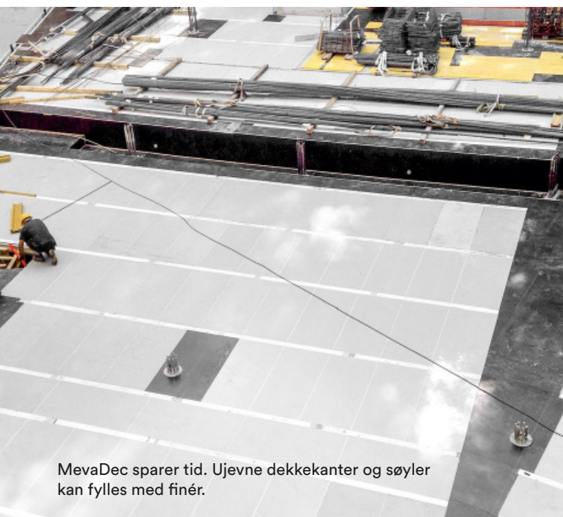
MevaDec med primærbjelker i to retninger.
