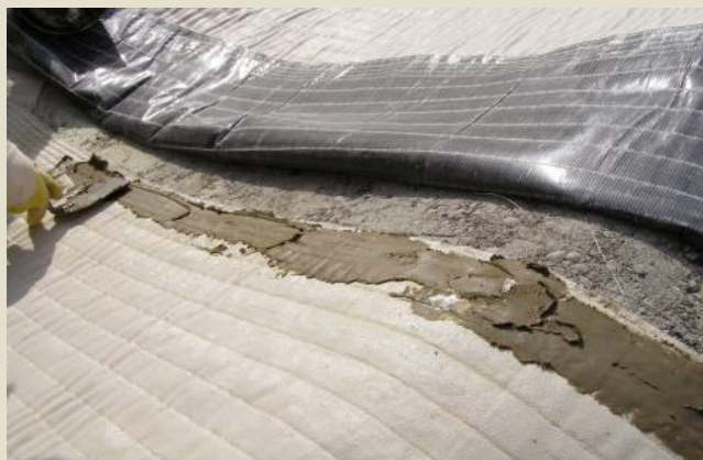
I overlappskjøter med CEMtobent DS Double Seal / CS-Plus bentonittmembraner.
