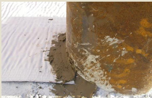
Mellom bentonittmembran og gjennomføringer.
