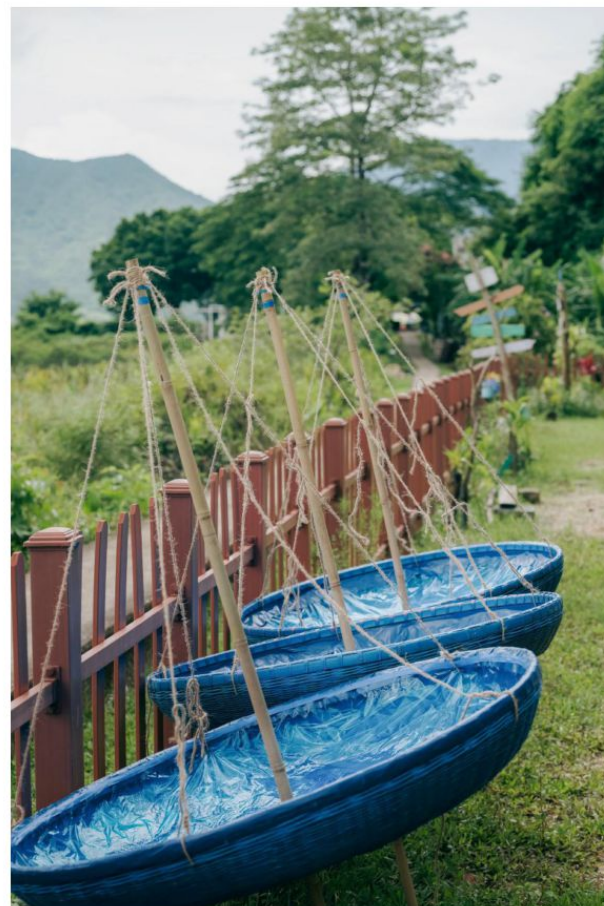
Blue Water Catcher di Canalside Studio è un prototipo inserito nello storico villaggio di Kuk Po, a Hong Kong, per raccogliere l'acqua piovana. Utilizza materiali del luogo, rattan e bambù, con tecniche costruttive facilmente replicabili in situazioni di scarsità di risorse.
