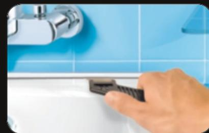
Den Dichtstoff durch Ziehen des Messers aus der Fuge heraus-schneiden. Dichtstoffreste auf glatten Flächen mit der Längsseite der Klinge durch vorsichtiges Schaben vollständig entfernen.
