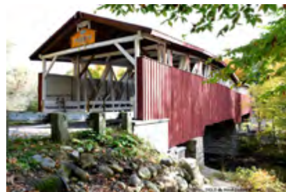
Pont couvert de Powerscourt (PERCY)
