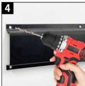
4) Verwenden Sie eine Bohrmaschine und Schrauben, um die Schienen sicher an der Wand zu befestigen.
