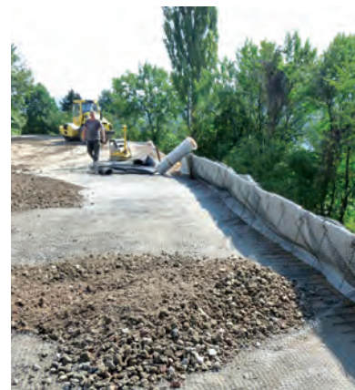
Placement of fill ▲
