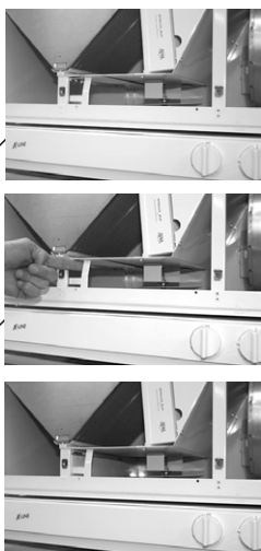
Spjället i sommarläge. Spjället ställs i vinterläge genom att man skjuter spjället bakom hållaren.
