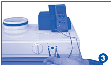
Mittaa jännite navoista – ja S, säädä esim. nopeus 1 potentiometrillä
