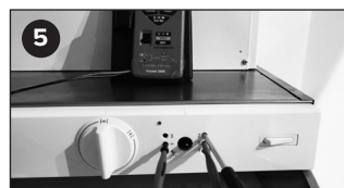
Mät spänningen vid polerna – och S, och ställ t.ex. in hastighet 2 vid potentiometer 2 osv.
