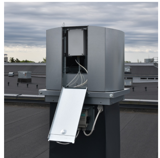
Kaikki ohjainlaitteet ovat integroituna huippuimurin sisälle turvaluukun taakse.
