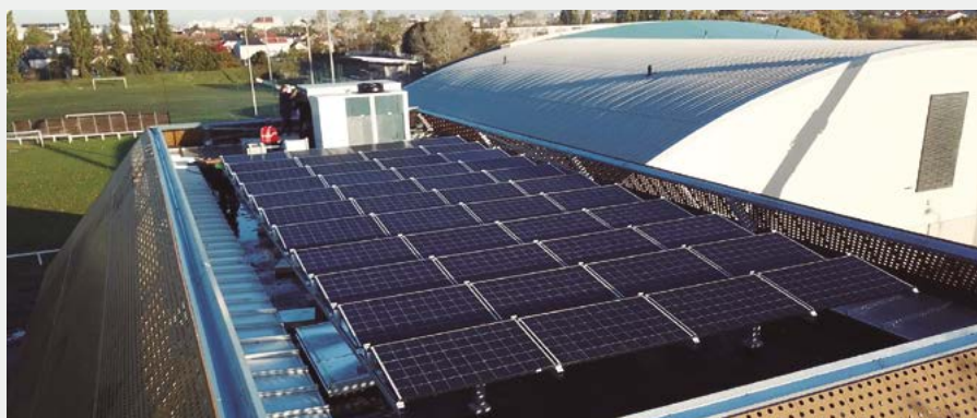
Amandiers Idrettsanlegg. Carrierre sur Seine, Frankrike. ECOi-W
