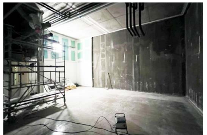
La fin du chantier est prévue pour cet été, et les premiers patients sont attendus dans le courant de l'automne prochain.
