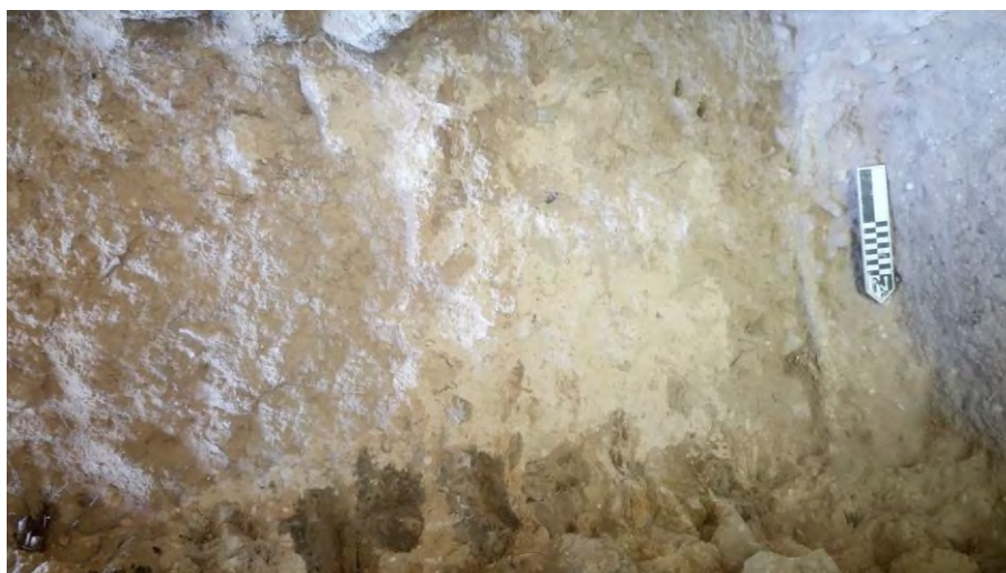
Figura 2.3 Fachada interior del Muro 2, correspondiente al Lote CR112B-24-3-7. Este muro conectaría con la esquina exterior de 13R-45 (Fotografía por A. González)
