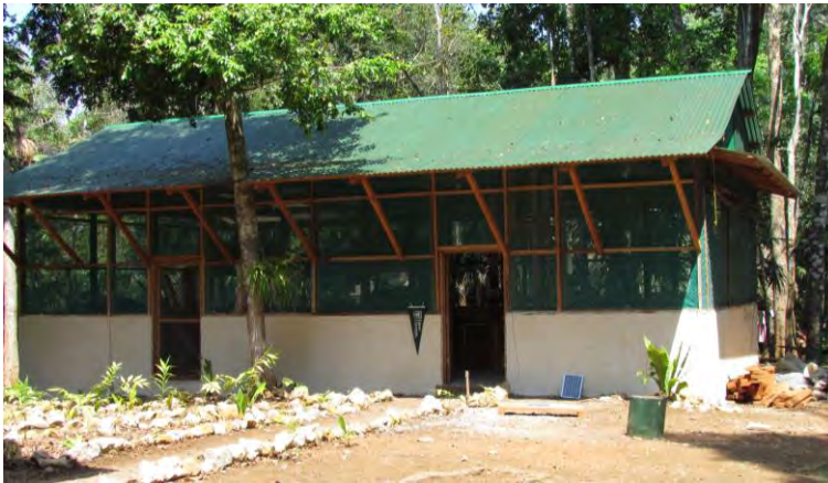
Figura 1.18 Edificios de oficina y bodega de materiales y herramientas, campamento PRALC (Fotografía T. Barrientos)
