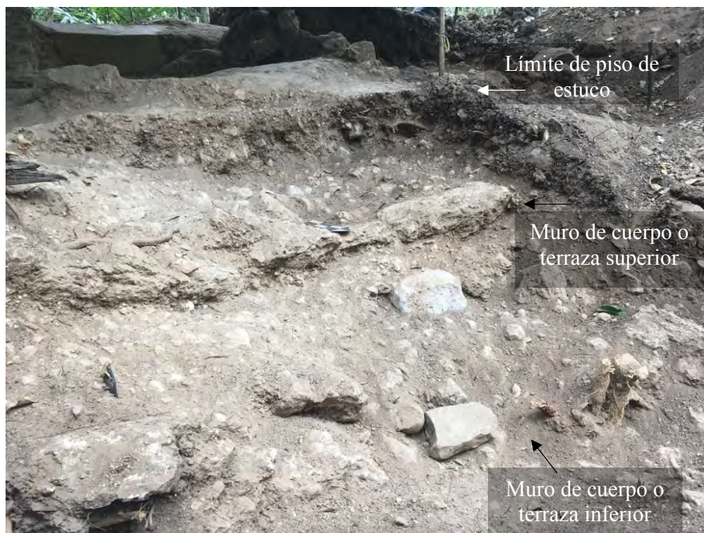
Figura 6.21 Muros de cuerpos o terrazas en la Fachada Norte de la Estructura 8M-1 a) vistos desde el noreste (Fotografía por J. Ponce)
