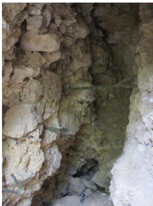
Figura 9.80 Túnel inferior del Saqueo #2, vista general luego de la limpieza (Fotografía por E. Arredondo).
