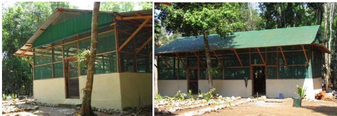
Figura 1.14 Edificios de oficina y bodega de materiales y herramientas, campamento PRALC (Fotografías por T. Barrientos)
