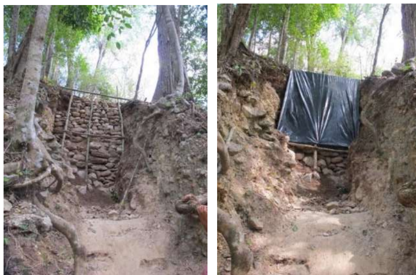
Figura 9.58 Saqueo #1, cobertura final luego de la intervención (Fotografías por E. Arredondo).
