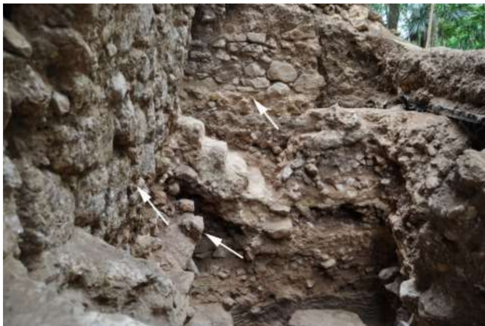
Figura 6.6 Muros de contención redefinidos en cuanto a sus límites en 2015. La flecha al fondo indica el Muro A; la flecha al frente e izquierda señala el Muro B; la flecha al frente y derecha apunta al Muro C (Fotografía por E. Gómez).
