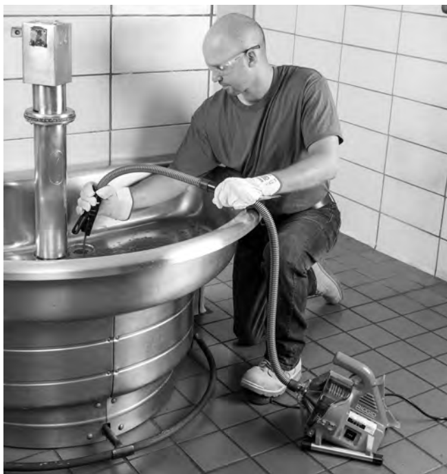
Figura 11 – Recuperación del cable
