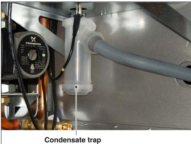
Fig. 19 Condensate trap
