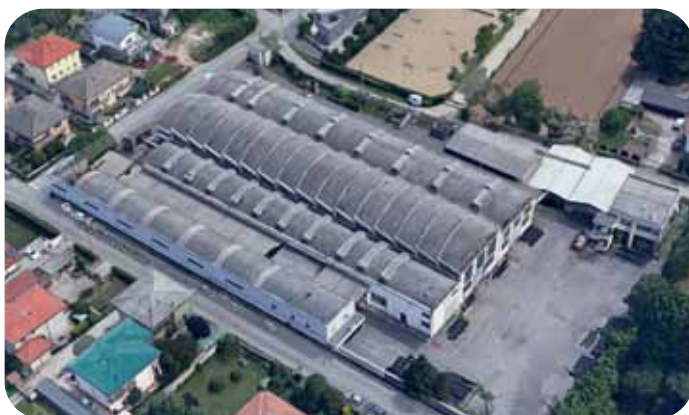
Production Facility - Borsano di Busto Arsizio (VA)
