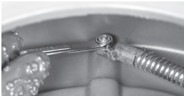
Figure 30 – Boulon de fixation de la queue de cochont
