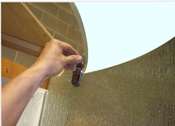
ÉTAPE 14 : Répéter les étapes 11 et 12 pour l'installation du linteau (3). Serrer l'écrou en acier (14D). Se reporter à la vue de détail I - Ensemble boulon/écrou (14) à la page 4 « Vue éclatée ».
