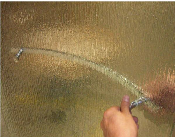
ÉTAPE 29 : Encocher la partie rigide de la bandelette magnétique (10) pour l'adapter de façon appropriée au joint d'étanchéité inférieur (16).
