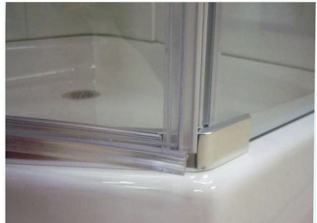
ÉTAPE 31 : Le sommet et le bas du panneau de porte (8) peuvent être ajustés pour améliorer le joint magnétique à la fermeture de la porte. Desserrer les écrous en acier (5J) et déplacer le panneau de porte (8) à gauche ou à droite.
