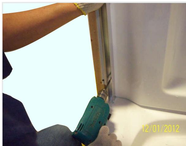
ÉTAPE 6 : Percer les trous à l'aide d'un foret de 1/8" et fixer le montant mural (1) à la paroi à l'aide des vis longues No 8 x 1" (11).
