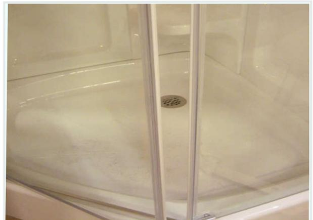
ÉTAPE 30 : La bandelette magnétique (10) doit être alignée comme montré. Fermer la porte et vérifier l'alignement des aimants.
