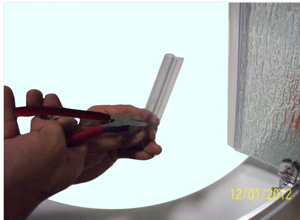
ÉTAPE 25 : Insérer le joint d'étanchéité inférieur court à balayage (15) sur la base en verre du panneau de porte (8) comme montré.
