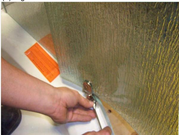
ÉTAPE 33: Appliquer un joint de silicone transparent résistant à la moisissure à l'extérieur de la cabine de douche de haut en bas des montants muraux (1, 1A).
