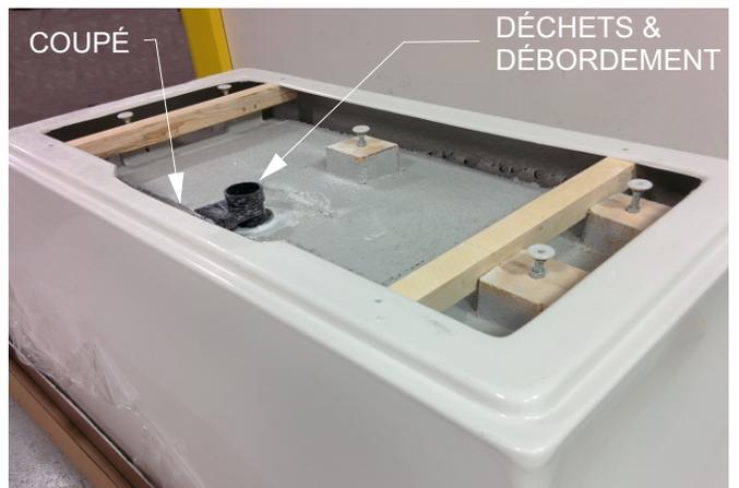
Étape 7 : Remplacez la baignoire à la bonne position, en la mettant de niveau si nécessaire (la baignoire est mise de niveau à l'usine). Ajustez le niveau de la baignoire en relâchant l'écrou hexagonal et en vissant la tige vers le haut ou le bas dans le bloc. Resserrez l'écrou hexagonal contre le bloc de bois quand le pied est de niveau. Raccordez la plomberie quand la baignoire est de niveau.
