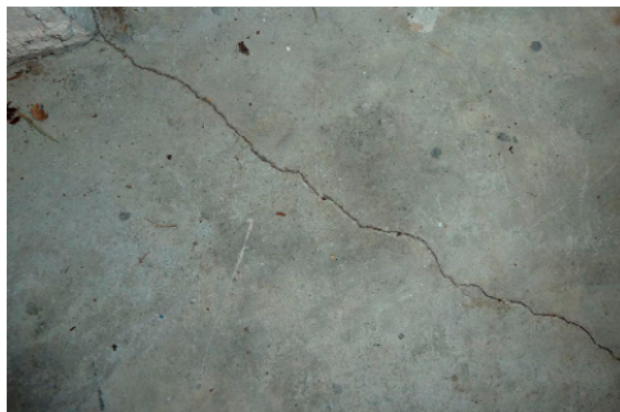
Krimpscheurtjes in vloer (<3 mm)
