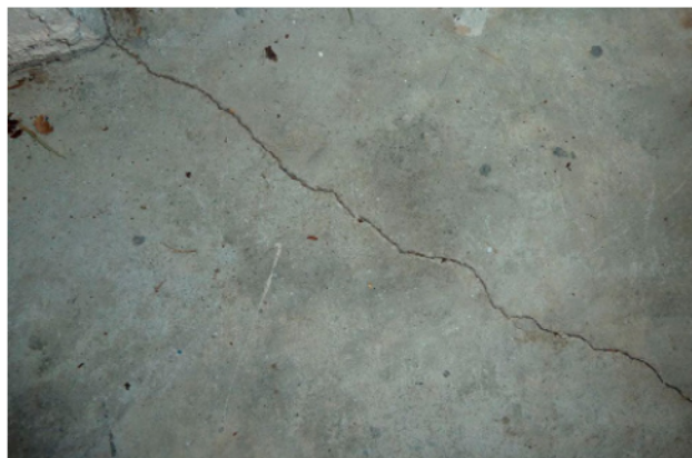
Krimpscheurtjes in vloer (<3 mm)
