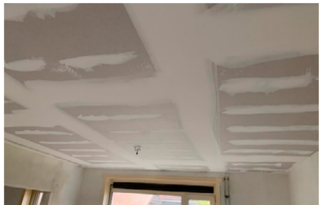
Nieuwe gipsplaten zijn dichtgesmeerd en schilderklaar
