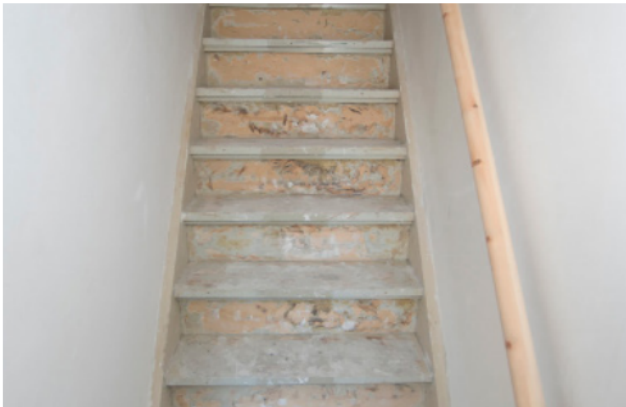
Trap met minimale lijmresten
