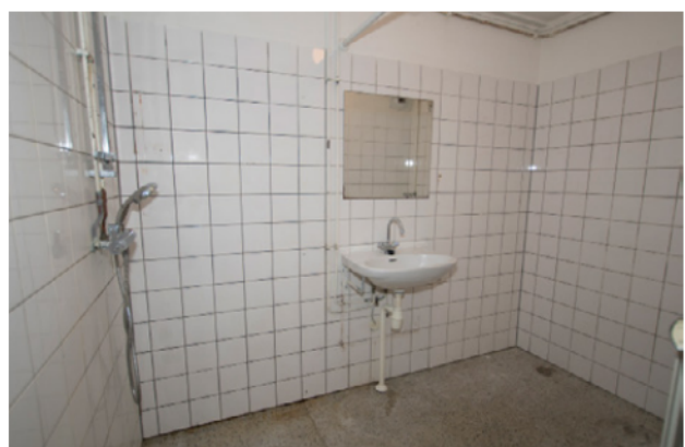
Badkamer niet goed schoongemaakt
