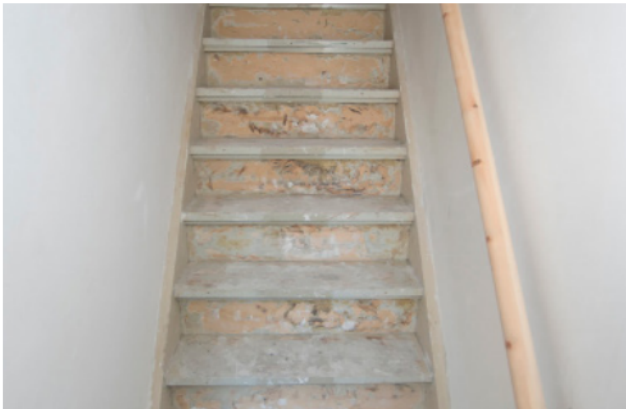
Trap met minimale lijmresten
