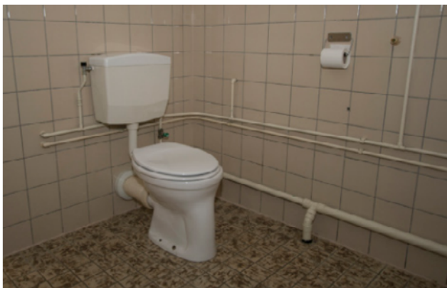
Toilet in goede staat
