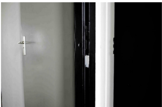
Donker kozijn gevuld met wit plamuur
