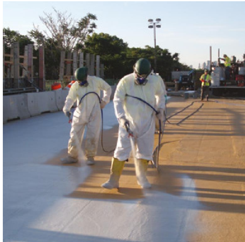
НАНЕСЕННЯ ДРУГОГО ШАРУ ELIMINATOR®
