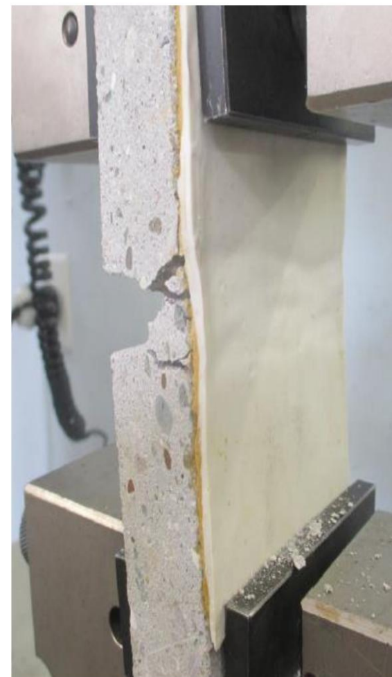
*Wydłużenie membrany przy pęknięciu podłoża 6,35mm
