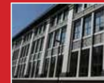
Ремонт та покриття бетону
