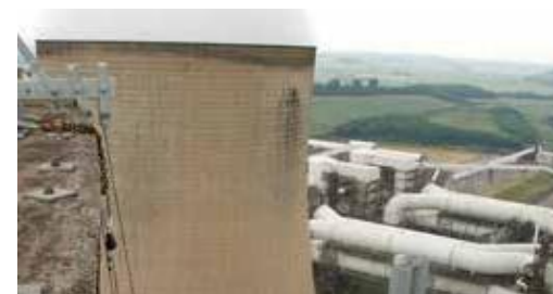
Ratcliffe Електростанція, Великобританія
