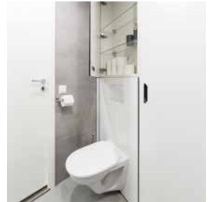
Seinään kiinnitetty wc-istuin.
