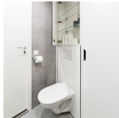
Seinään kiinnitetty wc-istuin.
