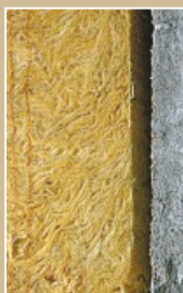
Утеплитель наружных стен из минеральной ваты
