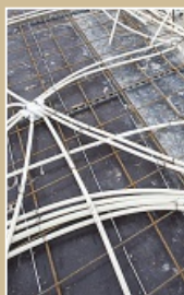
Разводка коммуникаций в толще монолитных перекрытий
