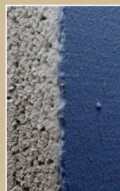
АСО-панели ванных комнат обработаны гидроизоляцией
