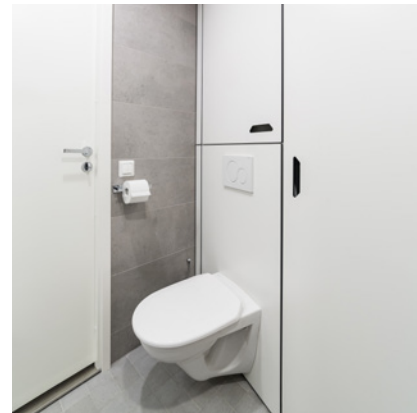
Seinään kiinnitetty wc-istuin.
